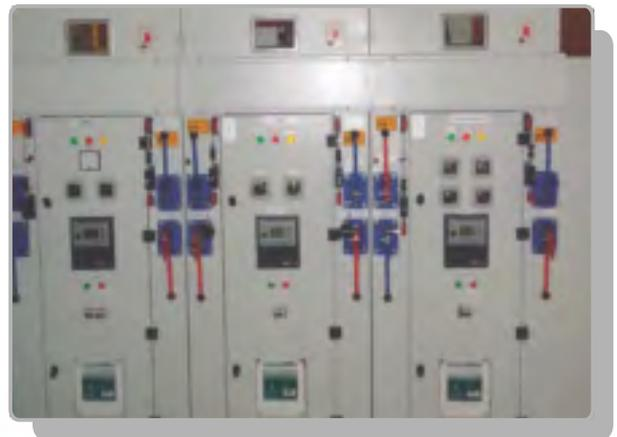
Высокая надежность сборки и входящего в КСО - 299 оборудования сводит к минимуму затраты на ремонт и обслуживание, а установленные механические и электромагнитные блокировки, исключают ошибочные операции персонала.
