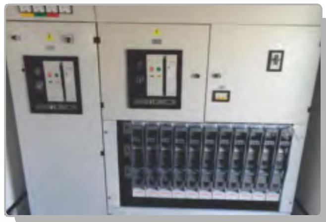
Корпус ШРНН сборный, на основании клепально-болтового соединения. Оборудование комплектуется таким образом, чтобы персонал имел доступ для проведения работ по осмотру и ремонту оборудования.
